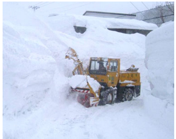
ロータリ除雪車による拡幅作業
