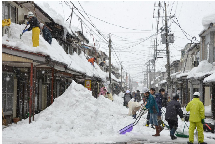
写真－2 高田地区の一斉屋根雪おろし
